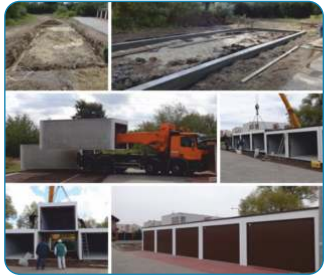
Etapowy proces budowy garaży.
