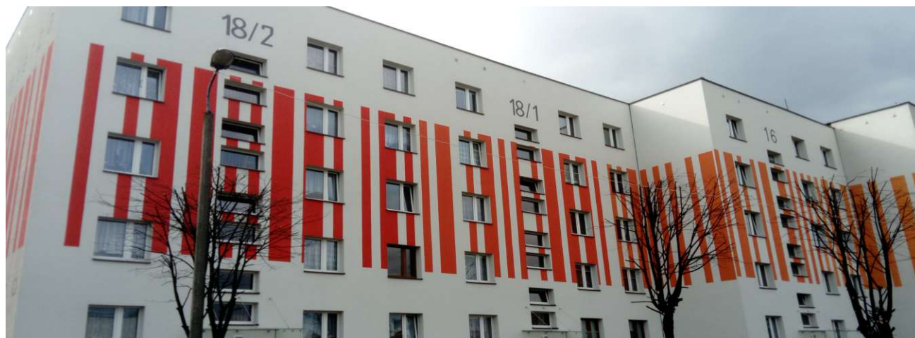
Budynek przy ul. Kazimierza Wielkiego 16, 18 po dociepleniu.
