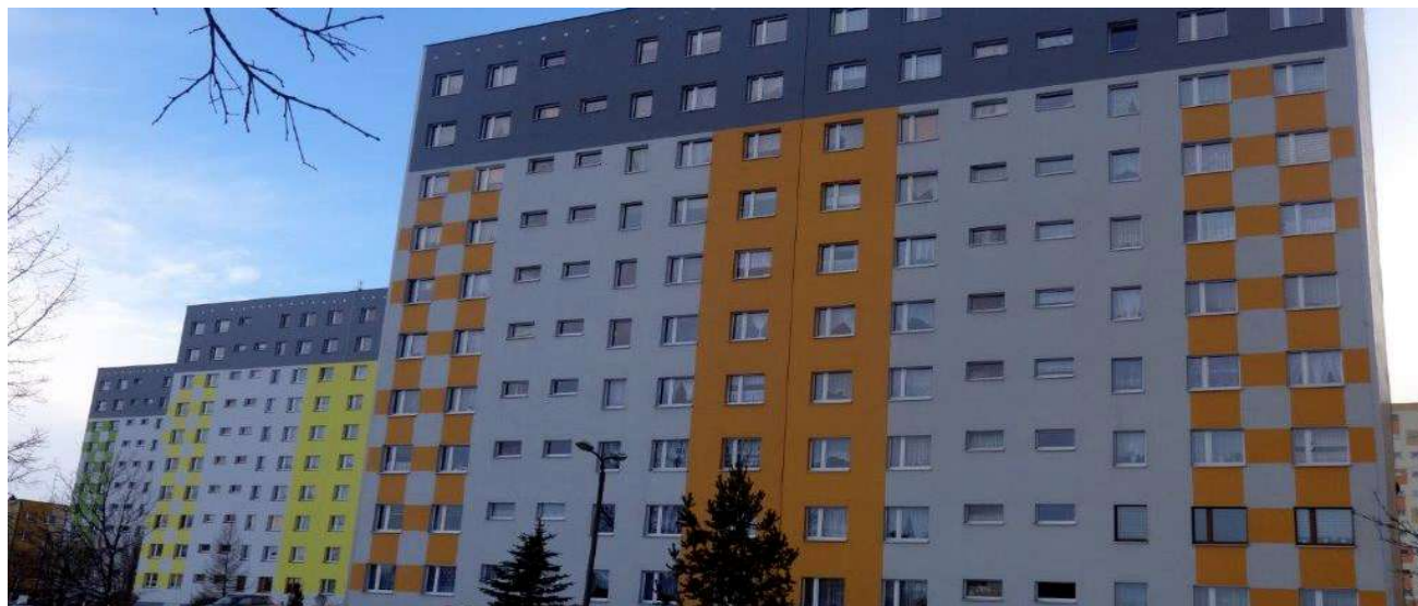
Docieplone budynki przy ul. Skłodowskiej - Curie 111, 113, 115.
