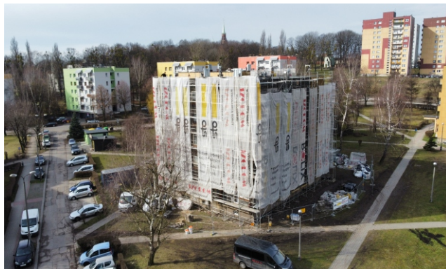
Budynki przy ul. Piotra Skargi 28, 30 w trakcie termomodernizacji przy wsparciu finansowym Banku Gospodarstwa Krajowego.
