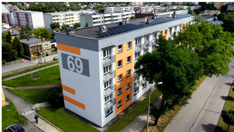
Budynek przy ul. Skłodowskiej - Curie 69 po kompleksowej termomodernizacji przy wsparciu finansowym Banku Gospodarstwa Krajowego.
