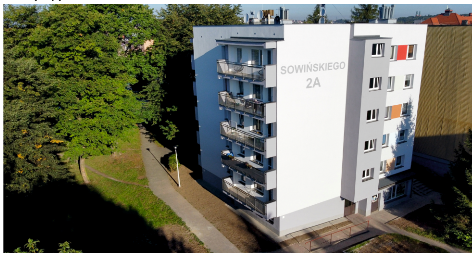
Budynek przy ul. Sowińskiego 2a po kompleksowej termomodernizacji przy wsparciu finansowym Banku Gospodarstwa Krajowego.
