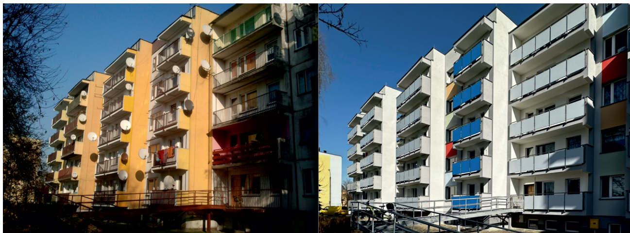
Budynek przy ul. Sowińskiego 2 przed i po kompleksowej termomodernizacji przy wsparciu finansowym Banku Gospodarstwa Krajowego.
