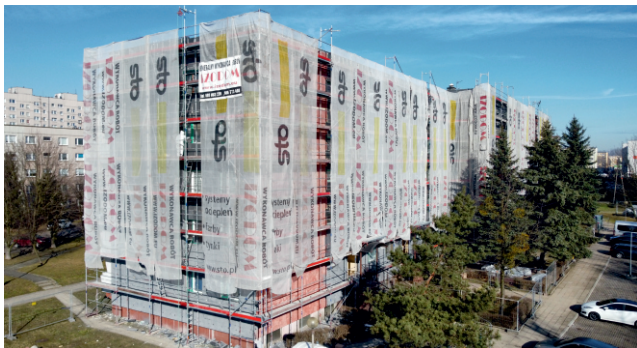
Budynek przy ul. Generała Jerzego Ziętka 66 w trakcie termomodernizacji przy wsparciu finansowym Banku Gospodarstwa Krajowego.
