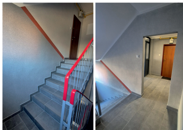
Klatka schodowa po kompleksowym remoncie w budynku przy ul. Skłodowskiej – Curie 97.
