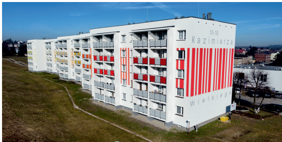
Budynek przy ul. Kazimierza Wielkiego 10-18 po kompleksowej termomodernizacji przy wsparciu finansowym Banku Gospodarstwa Krajowego.
